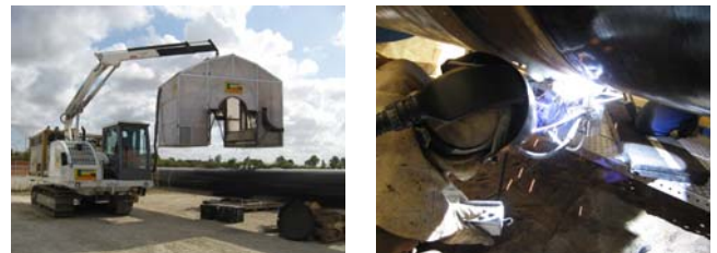
Bild 6: Baustellenbedingungen bei Verfahrensprüfungen
