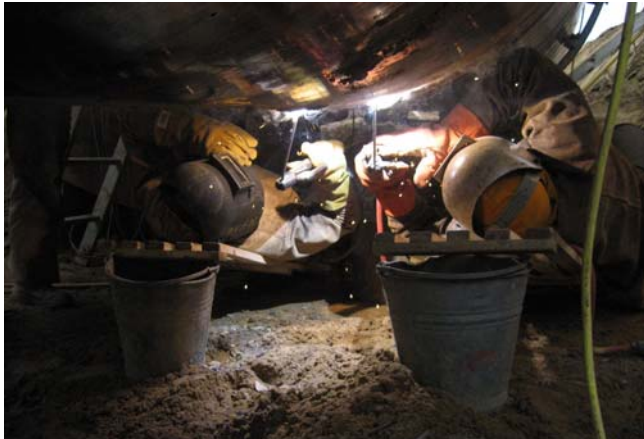
Bild 8: Schweißen im Rohrgraben
